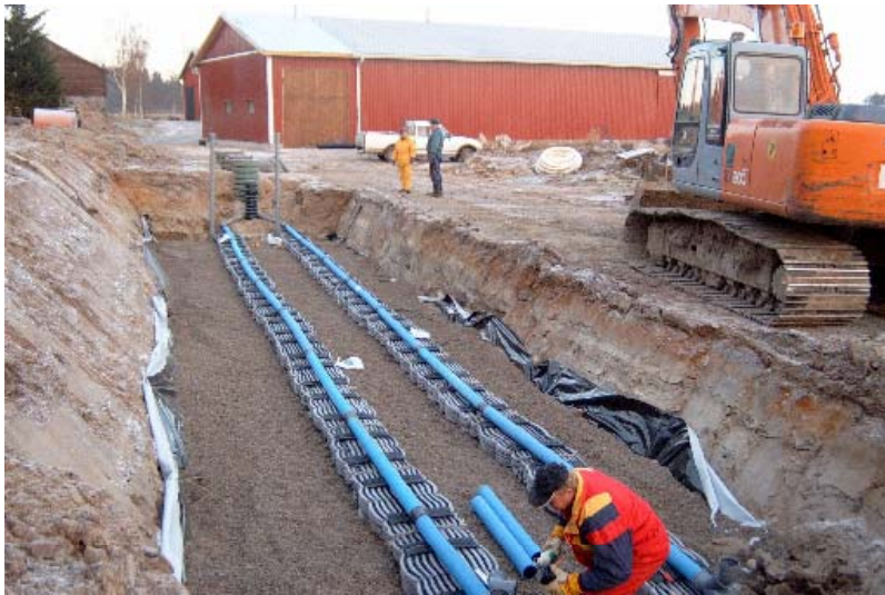
Kuva 1. Maitotilan jäteveden käsittelyjärjestelmän asennus Pietarsaaren maalaiskunnassa. (kuva Stefan Snellman)
